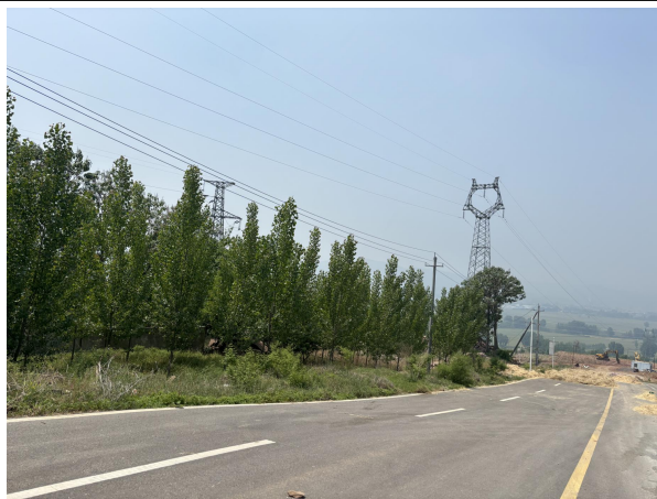
项目东南侧郑县万头红牛产业基地进厂道路
