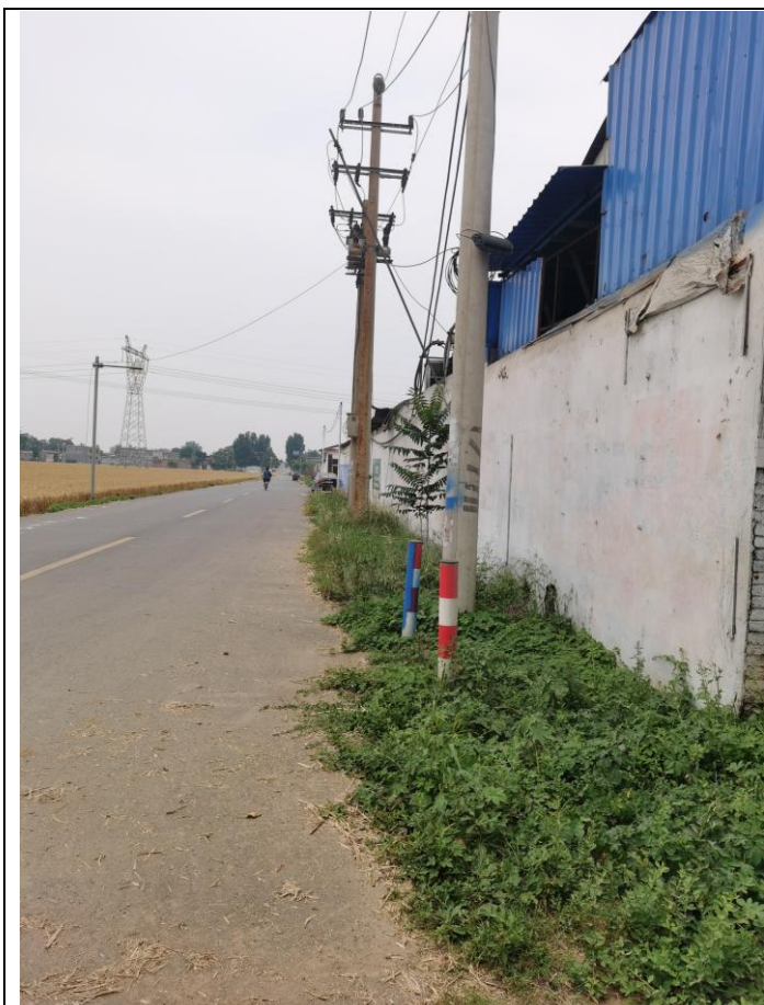
厂区南侧道路
